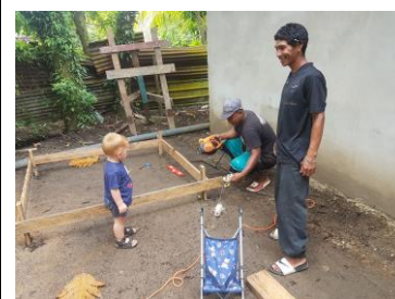
Snickare bygger vattentorn
